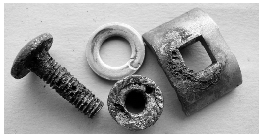
Bild 7. Komponenten einer Befestigung aus einem Straßentunnel bei falscher Werkstoffauswahl (© Bundesanstalt für Materialforschung und -prüfung, Berlin)
