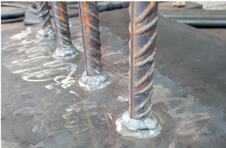
Bild 22: Beispiel für eine geschweißte Stirnplattennäht
