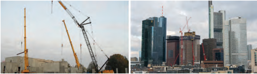
Abb. 2.13 a) Unbehinderte Montage mit Auto- und Raupenkränen, b) Montage in der Großstadt mit Hochbaukränen (Foto: Architekturforum).
