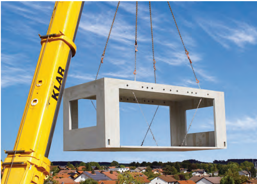
Abb. 2.8 Raummodul (Foto: Laumer Bautechnik).
