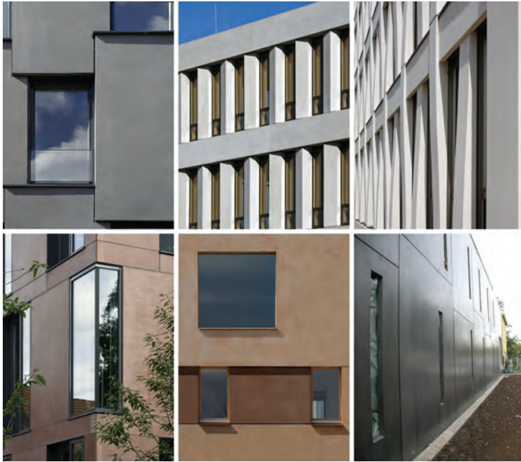
Abb. 7.1 Fassaden aus Architekturbeton (Fotos: FDB-Mitgliedsunternehmen).
