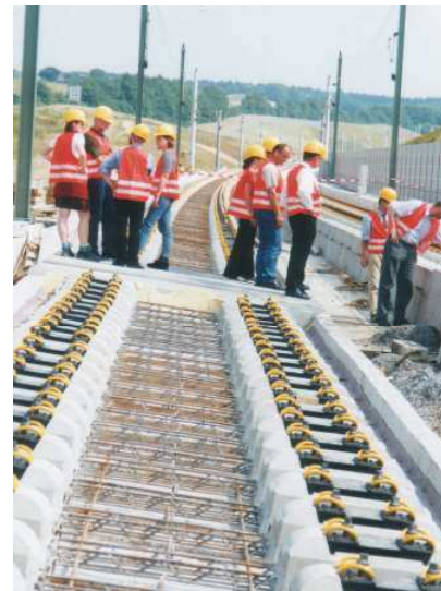
Bild 2.5 Überhöhung im Kreisbogen (im Bau)
