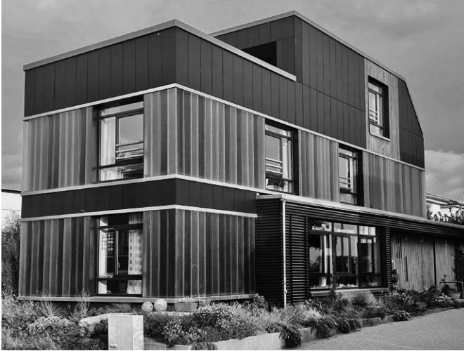
Bild 1.1 Nachhaltiges Bauwerk in Hannover
