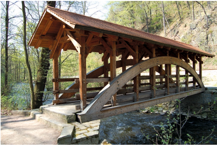
Bild 1.3 Baulicher Holzschutz bei einer Brücke
