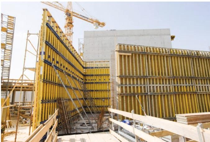
**Bild 5.1** Holzträgerschalung für Wände, Bildquelle: Doka
