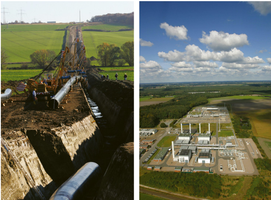
Bild 1.3 Links: Bau einer Erdgaspipeline in Ostdeutschland, rechts: Erdgasspeicher Rehden, 60 Kilometer südlich von Bremen für 4,2 Milliarden Kubikmeter Erdgas (Fotos: WINGAS GmbH)
