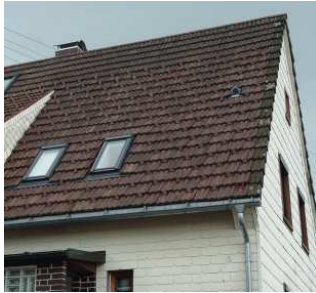
Bild 1-96: Unbelüftete Vollsparrdämmung unter Schalung mit Bitumendachbahn, darüber alte Ziegelddeckung auf Lattung. Die Schalung unter der Bitumendachbahn zeigt starke Durchfeuchtung und Schimmelbefall. Zunächst war diffusionsbedingtes Tauwasser vermutet worden. Tatsächlich ist dieser Aufbau mit feuchtevariabler Dampfbremse diffusionstechnisch bewährt und in Ordnung. Schadenursache: Die alte Bitumendachbahn war durch Nägel so stark perforiert, dass Treibregen und Flugschnee den Weg in die Schalung fanden. Diesen Wassereintrag kann auch die vorliegende Konstruktion nicht schadlos kompensieren.
