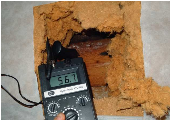
Bild 1-96: Unbelüftete Vollsparrdämmung unter Schalung mit Bitumendachbahn, darüber alte Ziegelddeckung auf Lattung. Die Schalung unter der Bitumendachbahn zeigt starke Durchfeuchtung und Schimmelbefall. Zunächst war diffusionsbedingtes Tauwasser vermutet worden. Tatsächlich ist dieser Aufbau mit feuchtevariabler Dampfbremse diffusionstechnisch bewährt und in Ordnung. Schadenursache: Die alte Bitumendachbahn war durch Nägel so stark perforiert, dass Treibregen und Flugschnee den Weg in die Schalung fanden. Diesen Wassereintrag kann auch die vorliegende Konstruktion nicht schadlos kompensieren.
