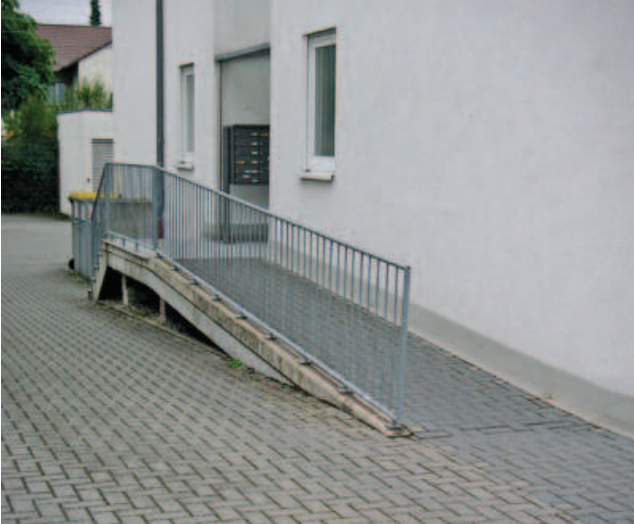
Abb. 6.58: Dieser Wohnhauseingang zeigt, dass Barrierefreiheit auch mit einfachen Mitteln möglich ist. Der Hauptzugang führt über eine Rampe, nur nach hinten zu den Stellplätzen gibt es eine Treppe.
