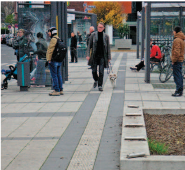
Abb. 6.8: Niedrige Hindernisse werden leicht übersehen und, wenn der Stock dem Leitstreifen folgt, auch nicht immer ertastet. Deshalb muss der Abstand zum Leitstreifen mindestens 60 cm betragen.
