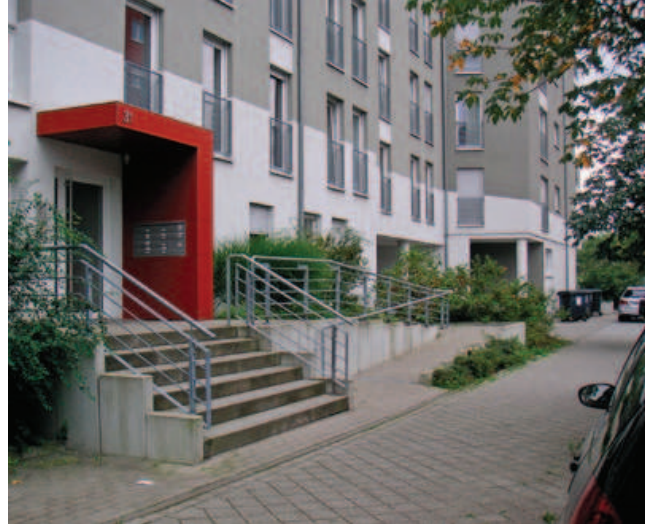
Abb. 6.59: Wohnhauseingang in Frankfurt-Rebstockpark mit einem Nebeneinander von Rampe und Treppe. Die rote Türeinfassung markiert auch für Sehbehinderte den Eingang.
