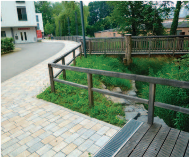
Abb. 7.35: Kontrastreicher, dem geringen Gefälle des Bestands folgender Gehsteig im Schlosspark Colpach (Quelle: GFLplan, Saarlouis)
