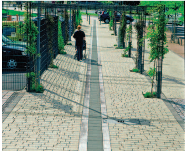
Abb. 6.7: Fußgängerweg in Marburg ohne äußere, mit dem Stock ertastbare Begrenzung. Orientierung bietet ein Leitstreifen aus Rippenplatten mit begleitendem Kontraststreifen. Um die Kontraste zu verbessern, wurde der alte Belag erneuert (vgl. Abb. 4.6.4). (Quelle: Rinn-Beton, Gießen)
