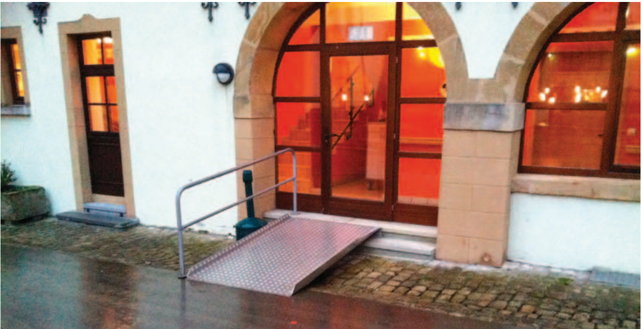
Abb. 6.60: Hauptmann's Schlass Berbourg mit einer eher provisorischen, aber komfortablen Stufenrampe als Zugang zum Seniorenheim. Damit wurde den Bedürfnissen der Bewohner entsprochen. (GFLplan, Saarlouis)
