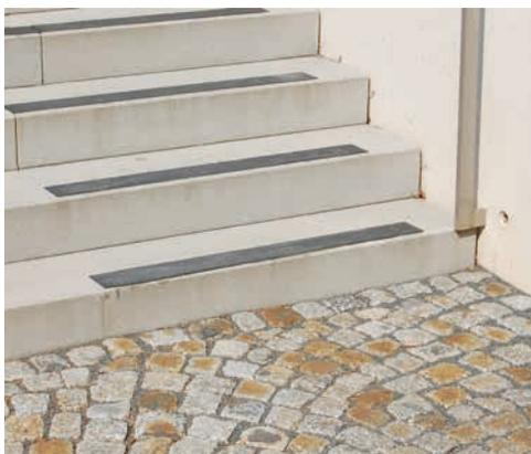
**Abb. C 1.38:** Treppe mit nachträglich aufgeklebter Stufenmarkierung
