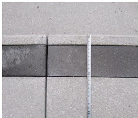
**Abb. C 1.39:** Treppe mit nachträglich eingelegerter Stufenmarkierung in die Trittstufe
