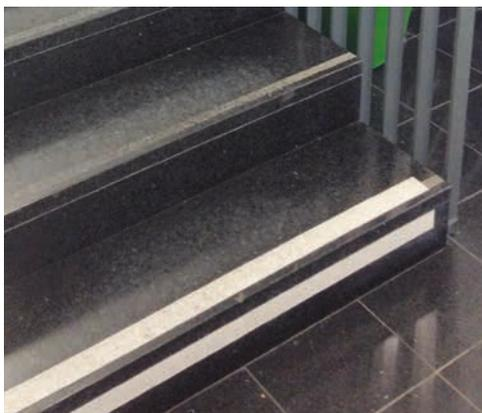
**Abb. C 1.31:** Nachrüstung einer Stufenmarkierung mit Abstand zur Stufenkante
