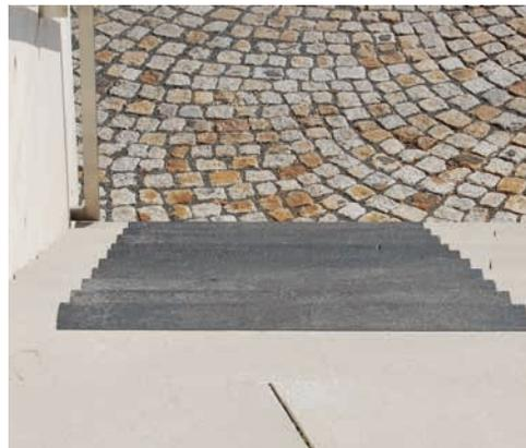
**Abb. C 1.37:** Betontreppe mit nachträglich auf die Trittstufe geklebter Stufenmarkierung – Die Stufenkanten als solche sind nicht erkennbar.
