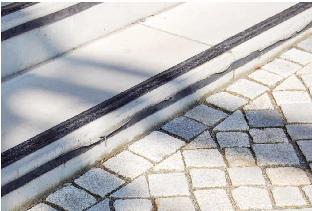
**Abb. C 1.33:** Ablösung einer nachgerüsteten, nicht dauerhaft haltbaren Stufenmarkierung im Detail
