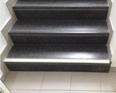
**Abb. C 1.34:** Nachträgliche Stufenmarkierung mit Kunststoffschiene
