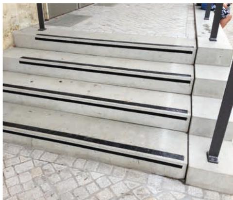
**Abb. C 1.32:** „Scheinstufeneffekt“ durch nachträglich aufgeklebte Stufenmarkierung
