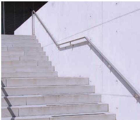
**Abb. C 1.36:** Betontreppe mit nachträglich aufgeklebter Stufenmarkierung (frontale Ansicht)
