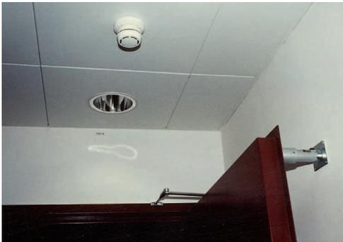
Abb. 4.6.5/24: Auch das Aufkeilen von Brand- oder Rauchschutztüren ist ein Verstoß gegen den §145 StGB; Abhilfe schafft eine Feststellvorrichtung, die im Brandfall automatisch schließt
