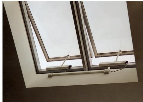
Abb. 4.6.5/25: Beispiel einer automatischen Treppenhaus-Entrauchungsanlage. Da Rauch nach oben steigt, wird das Treppenhaus weiter passierbar bleiben (Quelle: Scelsi)
