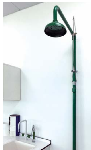
Notfalldusche (Bild: Zimmer)
