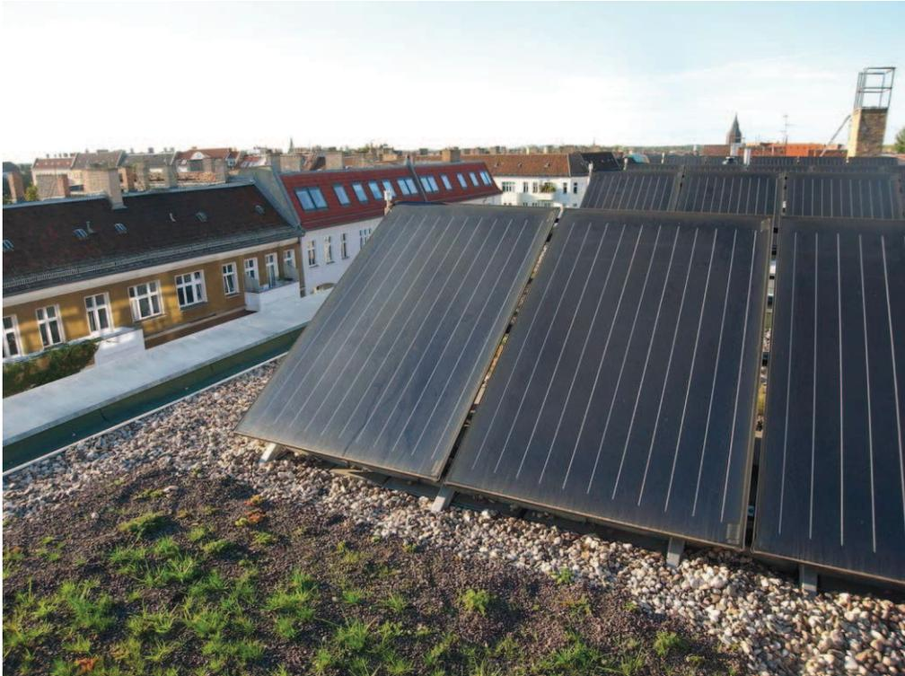
**Abb. 6.2:** Thermische Solaranlage zur Warmwasserbereitung
