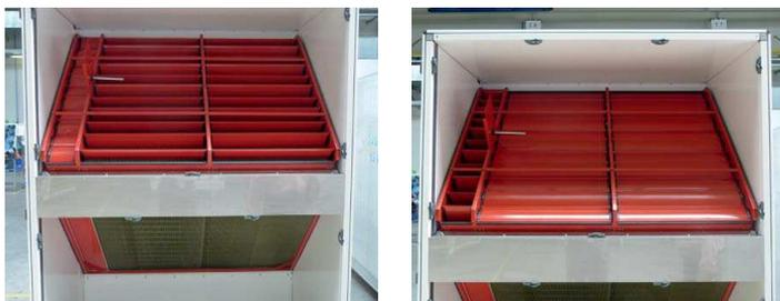
Abb. 2.11 und 2.12 Bypasslösung (jeweils links in den Abbildungen) zur Regelung der Wärmeübertragungsleistung bei einem Plattenwärmeübertrager (Quelle: M. Stahl)
