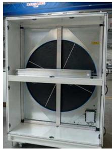
Abb. 2.15 und 2.16 Prinzipielle Darstellung der Wärmeübertragung in einem Rotationswärmeübertrager (Quelle: Klingenburg GmbH) und rechts ein Rotationswärmeübertrager mit Gehäuse zum Einbau in ein RLT-Gerät (Quelle: M. Stahl)
