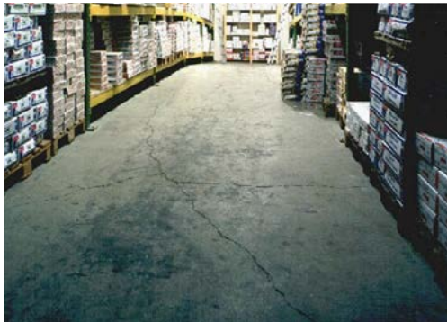
Abbildung 4 Durch Frost gerissener Boden und eingesunkenes Dach
