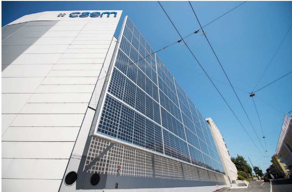
Auch große hinterlüftete Fassaden lassen sich mit Solarmodulen bauen, wie das Projekt am Forschungsgebäude des Centre Suisse d'Electronique et de Microtechnique (CSEM) in Neuchâtel zeigt. Durch die semitransparenten Module wirkt die Fassade trotz ihrer riesigen Ausmaße dennoch leicht. (© CSEM SA/David Marchon)
