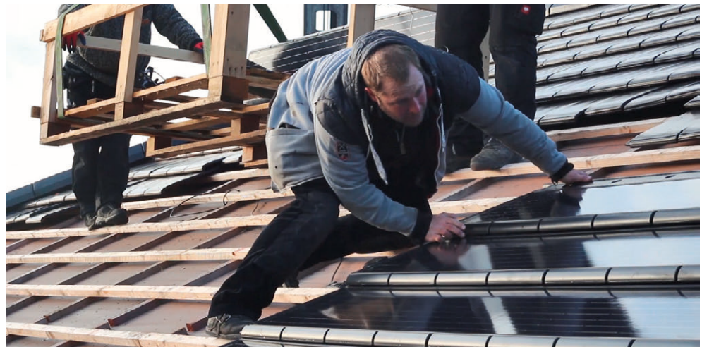
Eindeckung eines Schrägdachs mit solaren Ziegelementen – hier dem G10 PV. (© Dachziegelwerke Nelskamp GmbH)
