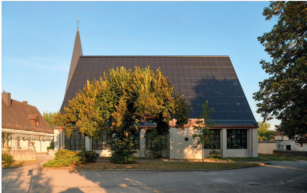
Bei der Begehung vor dem Baubeginn lässt sich feststellen, ob die Module verschattet sind. Hier wirft die alte Linde in den frühen Morgenstunden einen Schatten auf das Dach. Der verschwindet aber, wenn die Sonne in den nächsten Stunden weiterwandert. (© SOLARWATT GmbH)
