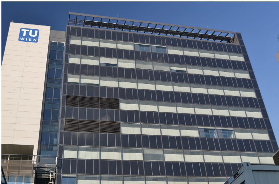
Die Fassade des Chemiehochhauses der TU Wien wurde schon ursprünglich in einer Pfosten-Riegel-Bauweise errichtet. Hier wurden bei der Sanierung die inaktiven Elemente durch Solarmodule ersetzt. (© Velka Botička)
