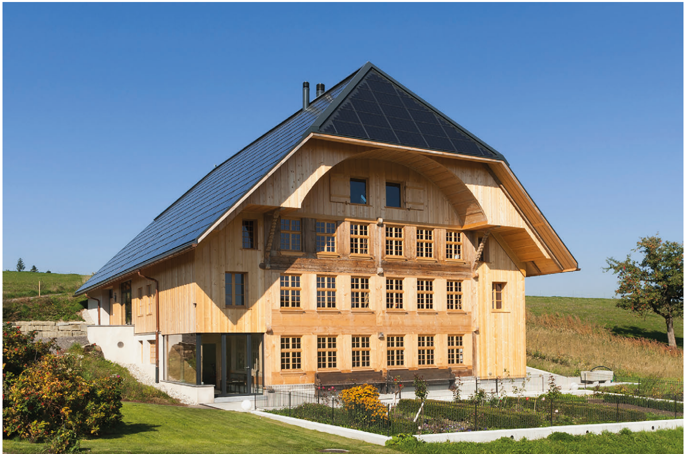
Am Rande des kleinen Örtchens Affoltern im schweizerischen Kanton Bern wurde ein altes und unter Denkmalschutz stehendes Gebäude komplett saniert. Dabei wurden die originalen Baumaterialien weitgehend erhalten. Allerdings wurde das gesamte Gebäude mit modernsten Mitteln gedämmt und auf Niedrigstenergiestandard gebracht. Die Energieversorgung übernimmt jetzt eine große Indach-photovoltaikanlage, die gleichzeitig die Dacheindeckung ist. (Planung, Bau und Bild by www.clevergie.ch )
