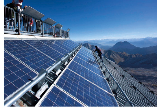
Indachanlagen können in luftigen Höhen ihre Vorteile ausspielen. Denn da sie in die Dachhaut integriert und linear gelagert sind, vertragen sie höhere Wind- und Schneelasten. (© Aleo Solar)
