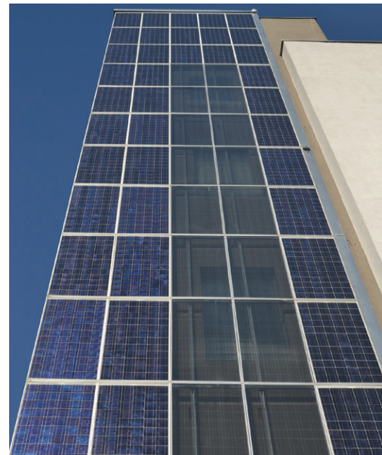
Strenge Gliederung und technische Optik: Das Gebäude der Ämter für Raumordnung, Natur und Umwelt im italienischen Bolzano ist teilweise mit einer vorgehängten Solarfassade ausgestattet. (© Velka Botička)
