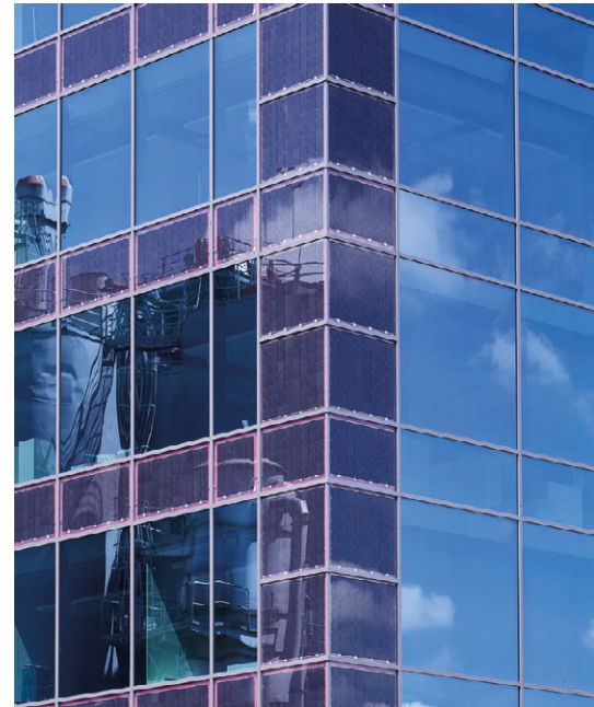
Eine filigrane Pfosten-Riegel-Konstruktion im Detail: Das neue Verwaltungs- und Bürogebäude von Swiss Krona in Menznau. (© Meyer Burger)
