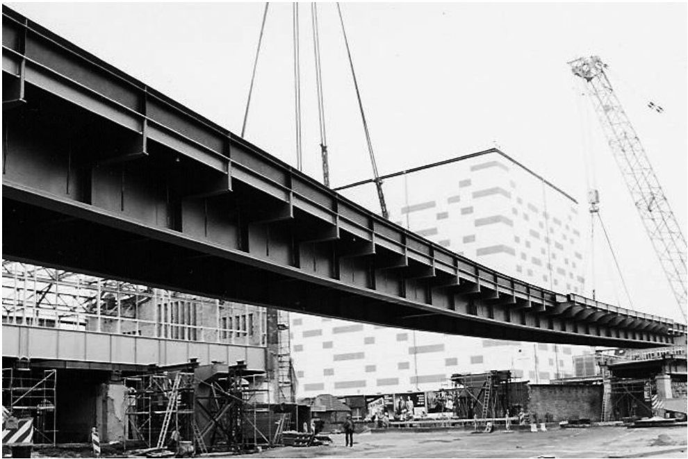
Abb. 7.1: Brückenmontage an einer Kreuzung (Foto: Konrad Micksch)
