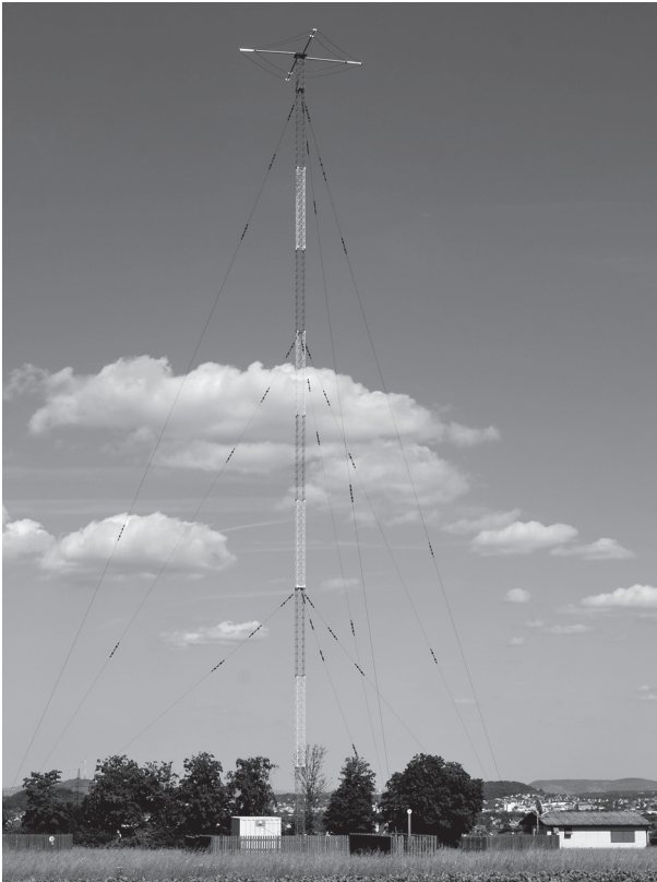
Bild 2.77 Beispiel für Antennenmast mit einer Höhe über 6 m – Sendeantenne für den Mittelwellensender der Deutschen Telekom AG in Ditzingen-Hirschlanden für das American Forces Network (AFN), im März 2014 abgeschaltet, 2015 abgebaut
