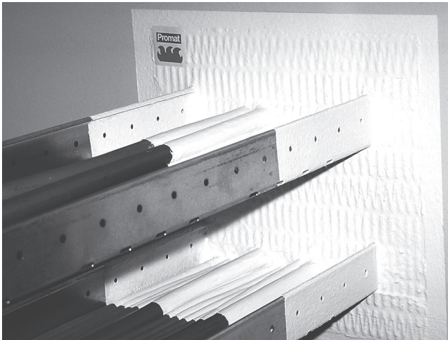
Bild 3.5 Mineralfaserplattenschott (Weichschott)
