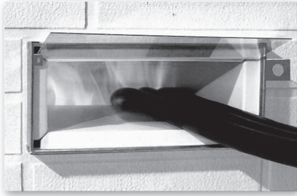
Bild 3.9 Brandschott mit speziellem Systemrahmen
