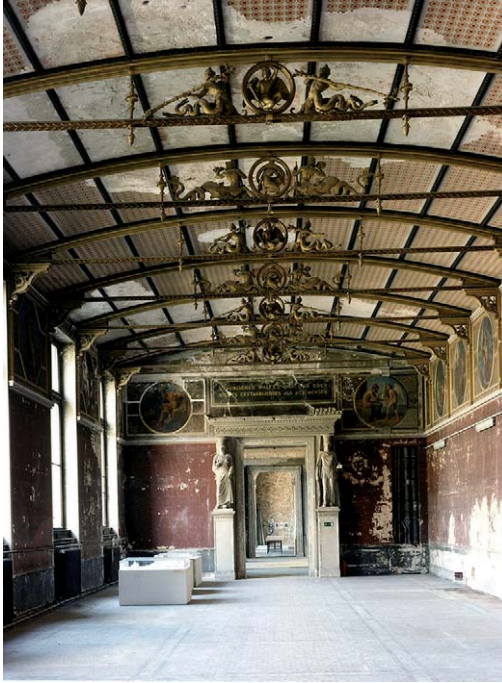
Bild 9.1 Rauchrohre der Heizungsanlage von 1848 im Niobidensaal (Fotograf unbekannt)
