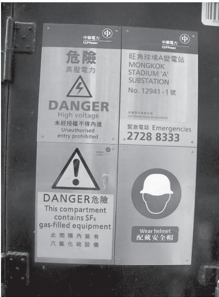
Bild 7.11 Sicherheitskennzeichnung auf der Stationstür einer Schaltanlage in Hongkong (China)
