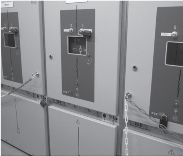
**Bild 7.12** Freischaltbereich zu Nachbarschaltfeldern mit rot-weißer Kette abgesperrt
