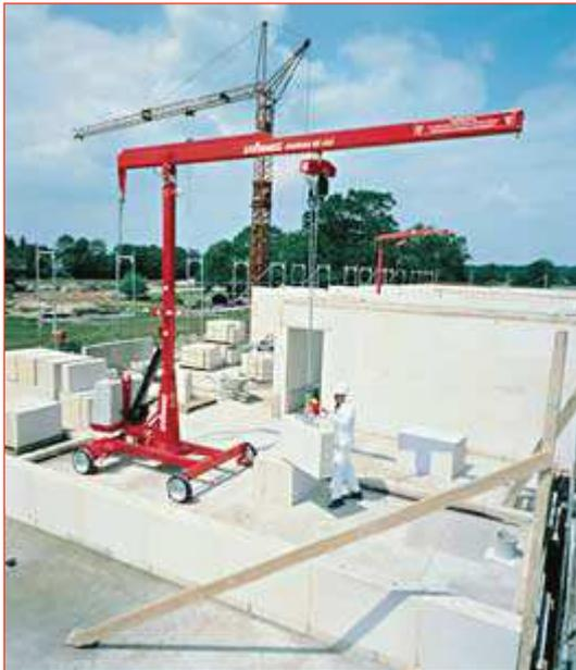
**Bild 2.3.13** Versetzgerät
