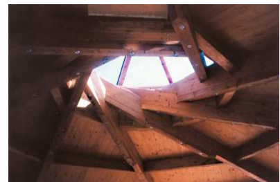
Bild 140: Blick in den oberen Teil eines ausgeführten Mandala-Daches (Zimmerer-Ausbildungszentrum Biberach a. d. Riss)
